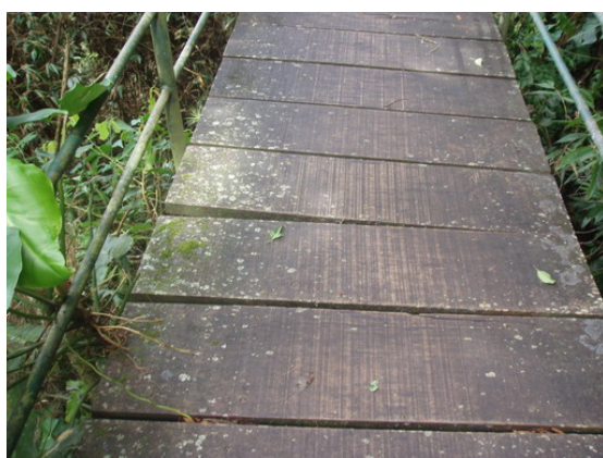
Figura 18 - Desnível das madeiras que compõe a trilha.
