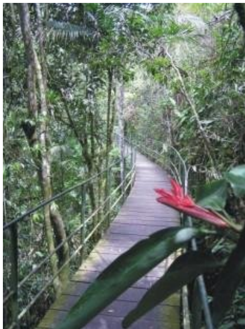
Figura 6 – Vista geral da trilha Suspensa
