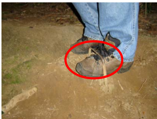
Figura 10- Altura do vergalhão exposto.
