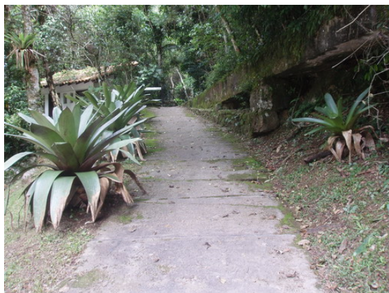
Figura 16 - Rampa de acesso a trilha suspensa.
