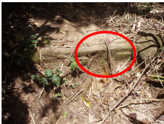
Figura 8 Detalhe do vergalhão
